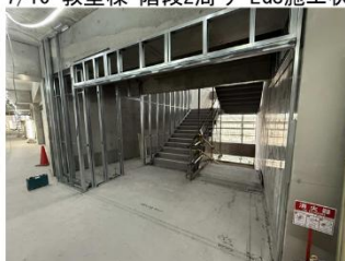
7/10 教室棟 階段2周り LGS施工状況 7/17 体育館棟 1階
